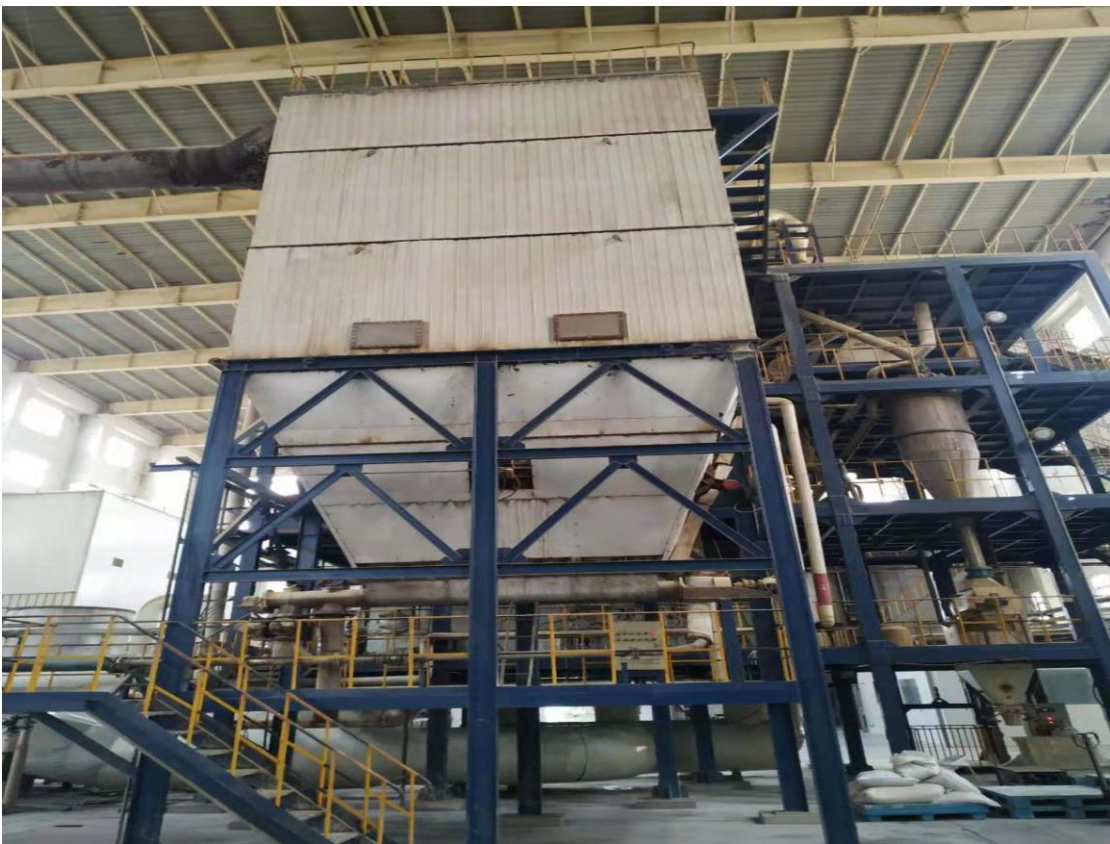
氨基酸颗粒剂滤筒除尘系统
